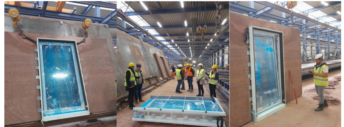
Beispiel vom Einbau eines Fensters im Werk Tinglev, 2023
